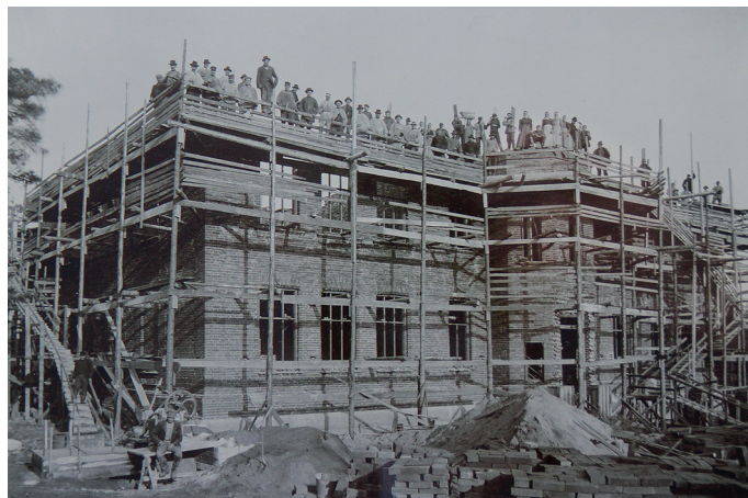
Realläroverket i Mariehamns uppbyggnad den 29 oktober 1902. Foto: L Bodnar, fotot tillhör Ålands museum
