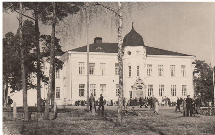
Realläroverket i Mariehamns uppbyggnad den 29 oktober 1902. Foto: L Bodnar; fotot tillhör Ålands museum.
